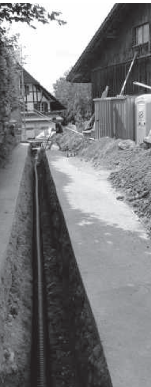
Impressionen der Verlegung der Fernwärmeleitungen
