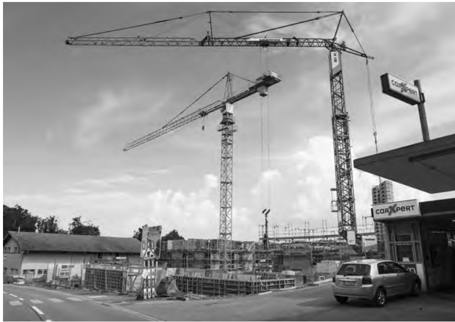
Wohnbau auf dem ehemaligen Sägerei-areal in Wohlen.
