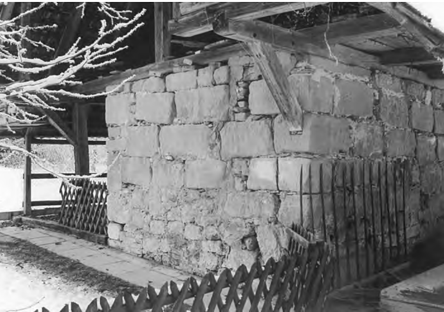
Ostseite des 2004 abgerissenen Backhauses in der Wohlei mit Sandsteinquadern von Alt-Bubenberg.
