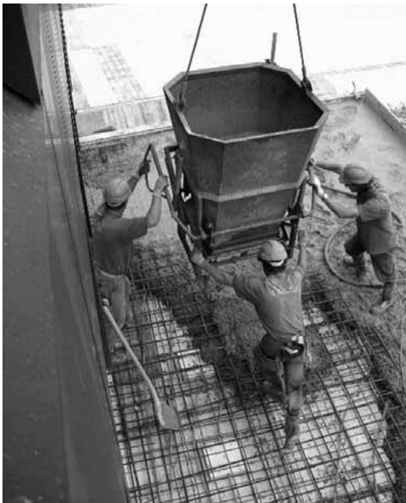
Das Einbringen des Betons auf dem neuen Flachdach ist Schwerarbeit, die genaues Arbeiten im Team erfordert. (Foto: Ueli Zimmermann)
