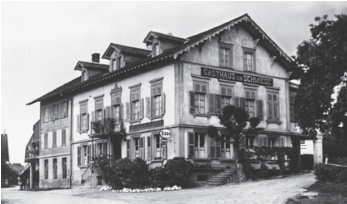
Gasthaus «zur Schmiede», Ortschwabenstrasse, Uettligen nach 1930 (Reprofoto von R. Schüepp, Uettligen)
