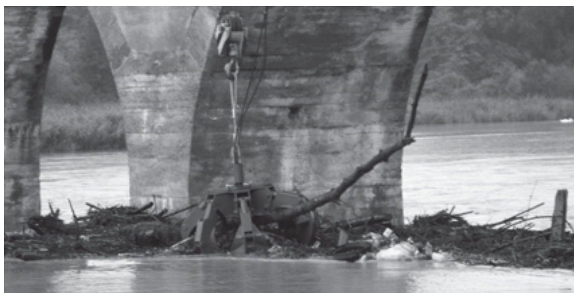
Entfernen des Schwemmholzes bei der Wohleibrücke mit dem Kranwagen der BKW
