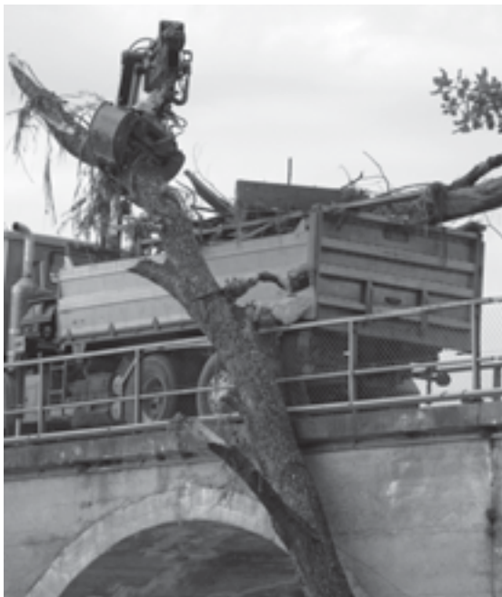
Entfernen des Schwemmhholzes bei der Wohleibrücke mit einem Lastwagenkran
