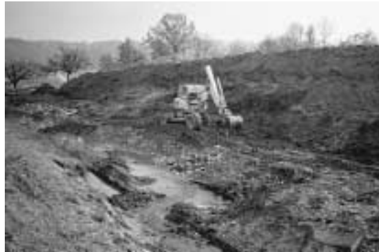
Der Mühlbach wird aus seinem Betonkanal befreit...
